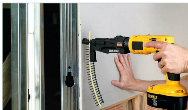
Montaggio di piastre di cartongesso su supporti di metallo
