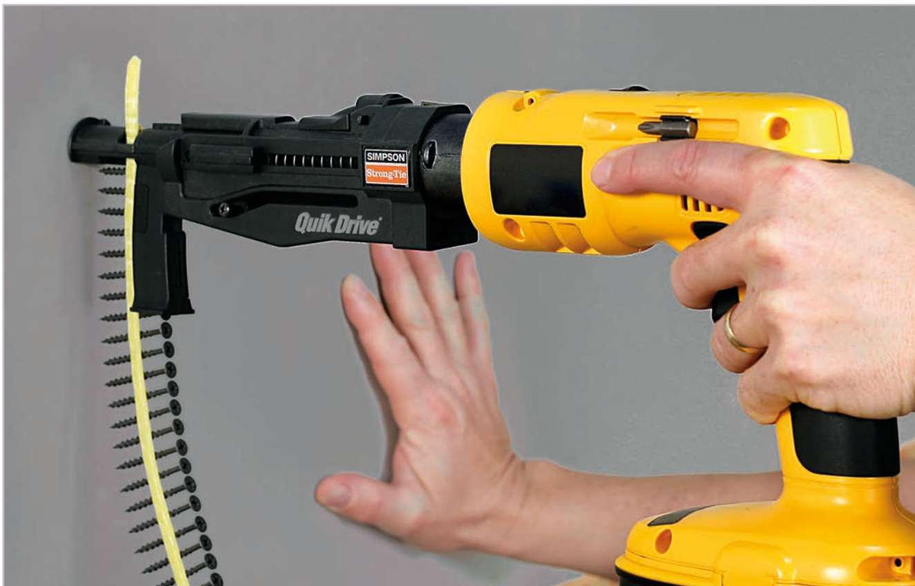
Montaggio di una piastra in cartongesso sul supporto in legno con viti per costruzione veloce DWC
