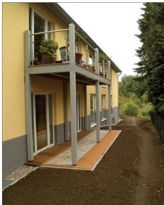
Installation de type balcon avec revêtement ouvert de la classe d'utilisation 3.
